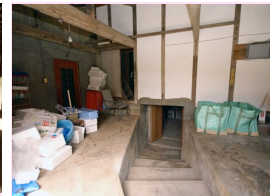
▲山野蚕種製造所・貯桑室と氷室
