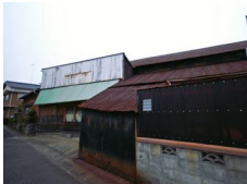
▲喜楽座・楽屋跡 裏側にはかつて楽屋があって、高窓から役者や顔を見せることもあったとか。屋根は手仕事で延ばした銅板が使われているそう。初期のトタン屋根の例としても貴重な。
