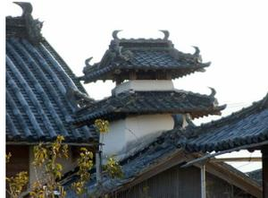
▲煙出しの小屋根の棟の向きが、カマヤの棟と直交している珍しい付き方だ。
